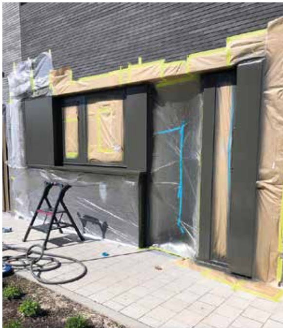
Immagine 3.14: Rifacimento mediante riverniciatura degli elementi in loco. © Respirepair
