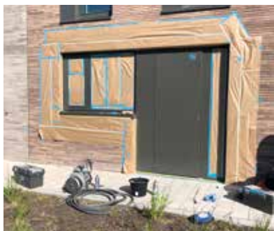
Immagine 3.32: protezione delle parti che vengono verniciate contemporaneamente. © Respirepair
